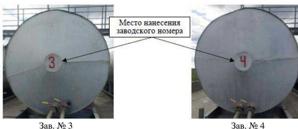
Рисунок 2 – Общий вид резервуаров модификации РГС-60
