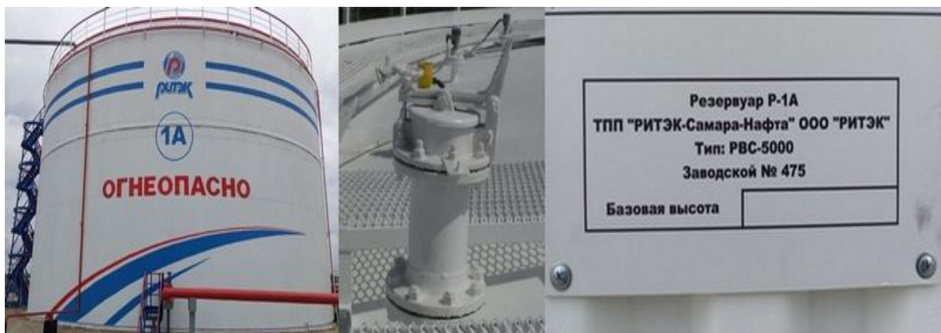
Рисунок 1 – Фотографии общего вида резервуара стального вертикального цилиндрического РВС-5000(№ 475), горловины замерного люка и заводского номера
