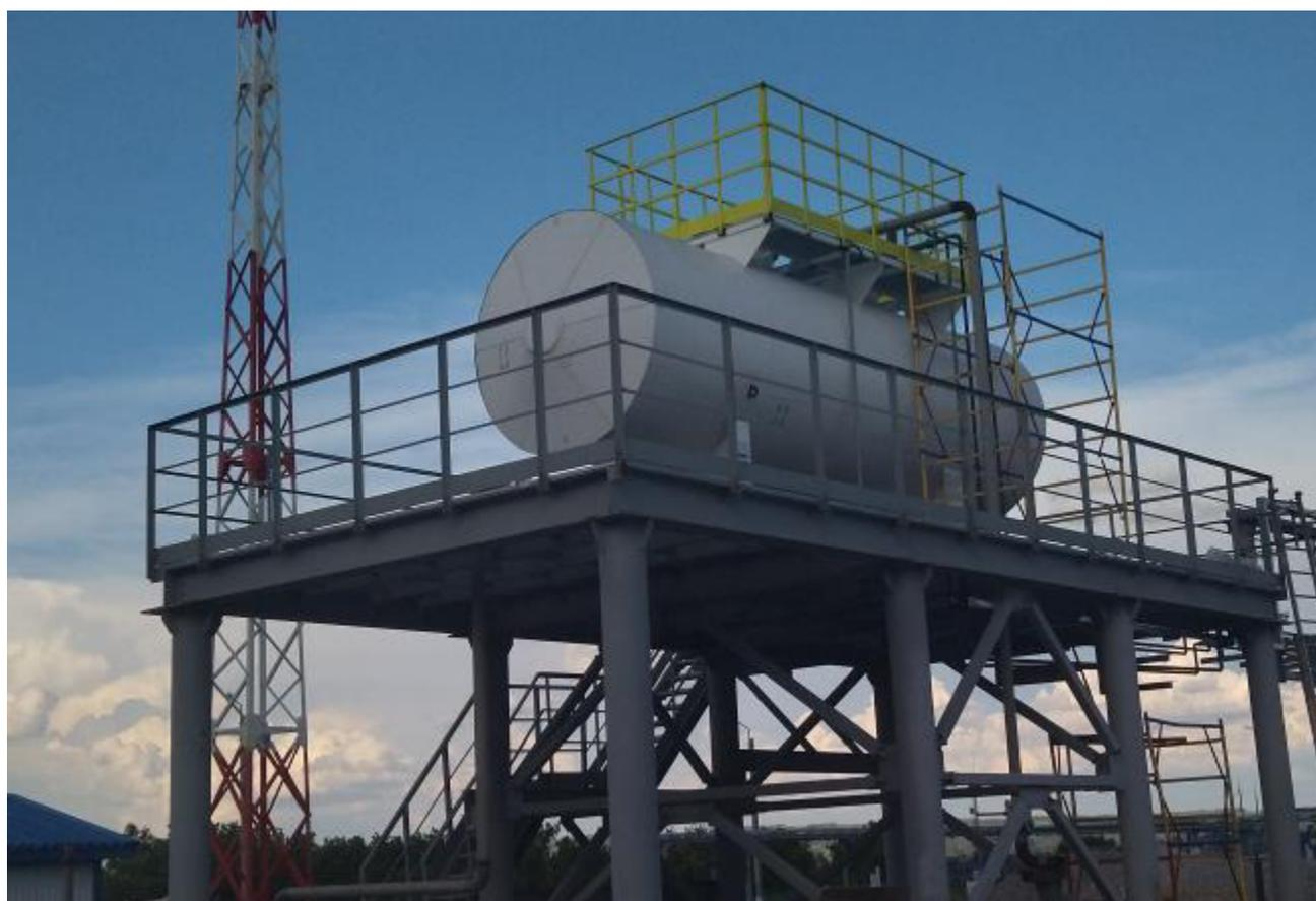
Рисунок 2 – Общий вид резервуара РГС-20-П4-Т-СО-У1
