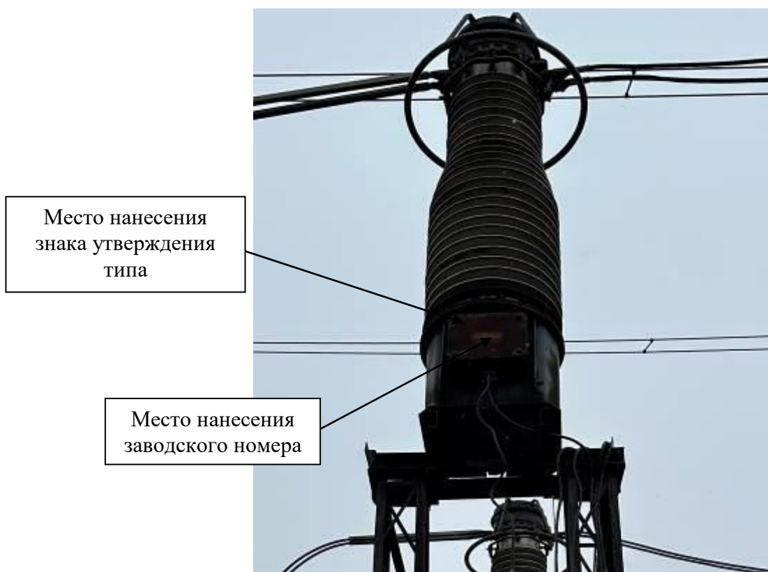
Рисунок 1 – Общий вид трансформатора тока
