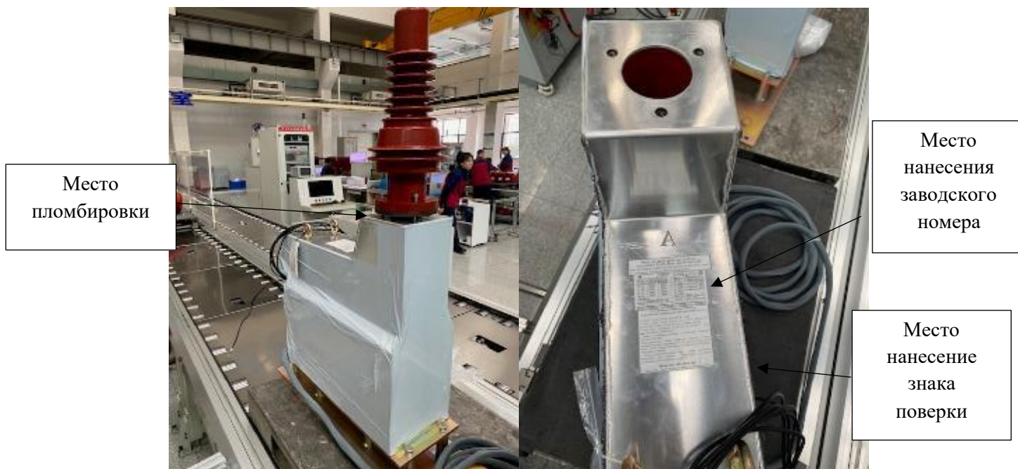
Рисунок 1—Общий вид трансформатора напряжения, место нанесения заводского номера, место нанесения знака поверки и место пломбировки от несанкционированного доступа
