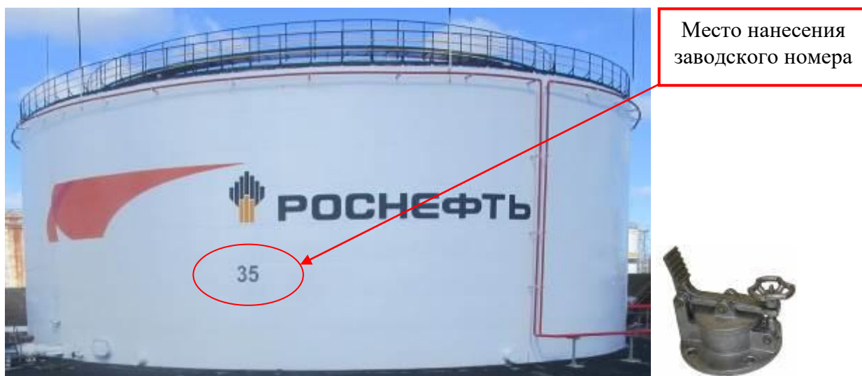
Рисунок 1 – Общий вид резервуара и замерного люка РВС-10000 зав.№ 35
