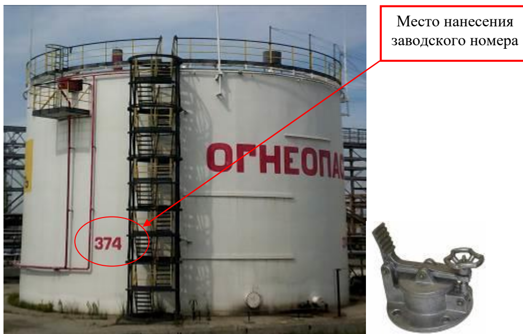
Рисунок 1 – Общий вид резервуара и замерного люка РВС-3000 зав.№ 374
