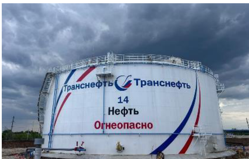
Рисунок 1 – Общий вид резервуара РВСП-10000
