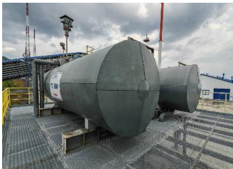
Рисунок 1 – Общий вид резервуаров РГС-20
