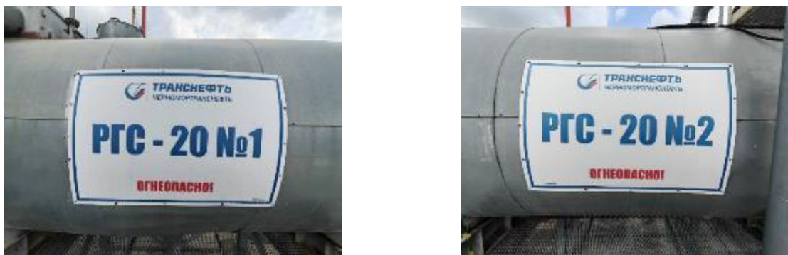
Рисунок 2 – Места нанесения заводских номеров резервуаров РГС-20
