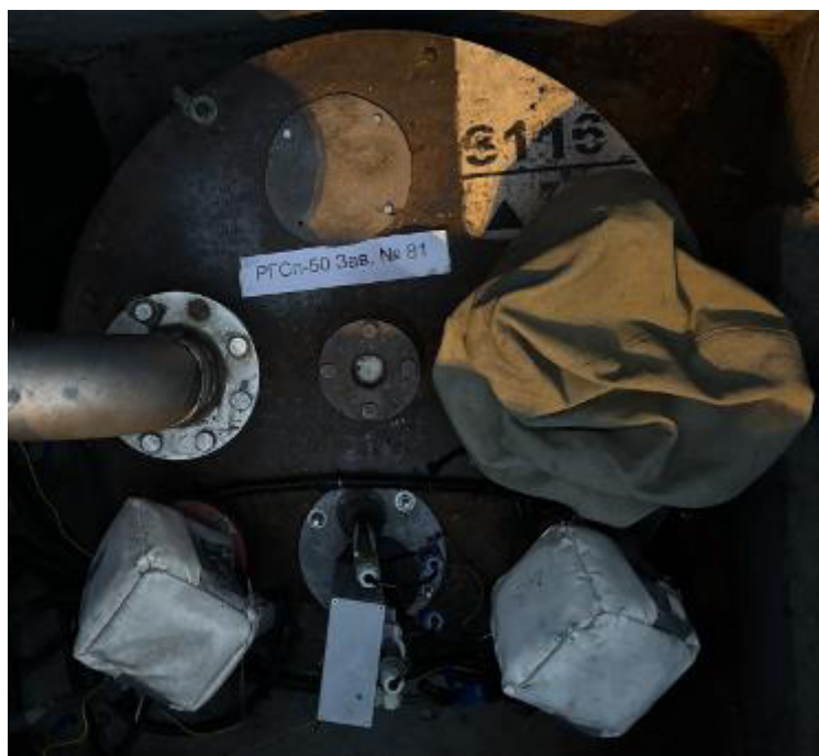
Рисунок 2 – Горловина резервуара РГСп-50 зав.№ 81
