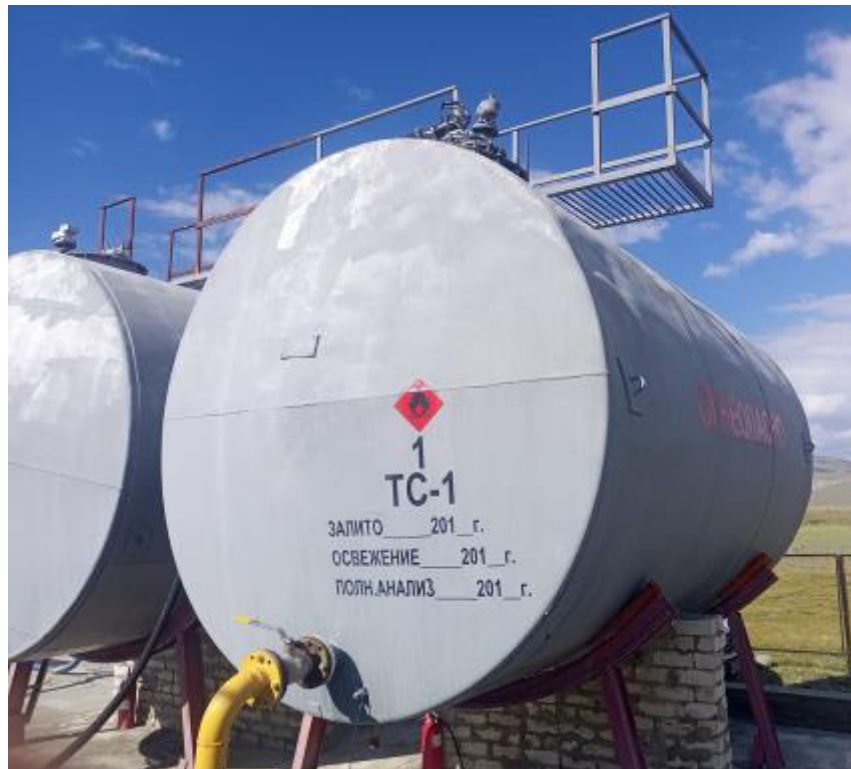
Рисунок 1 – Общий вид резервуара РГС-25 зав.№ 1
