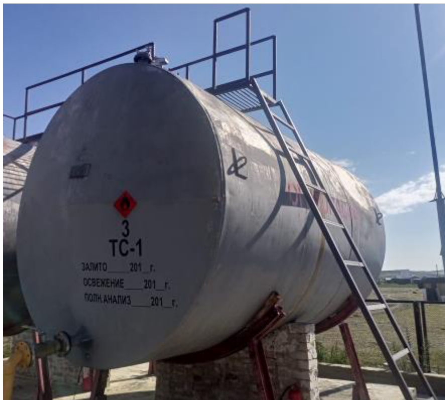
Рисунок 3 – Общий вид резервуара РГС-25 зав.№ 3
