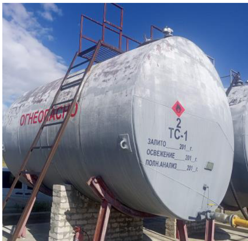
Рисунок 2 – Общий вид резервуара РГС-25 зав.№ 2
