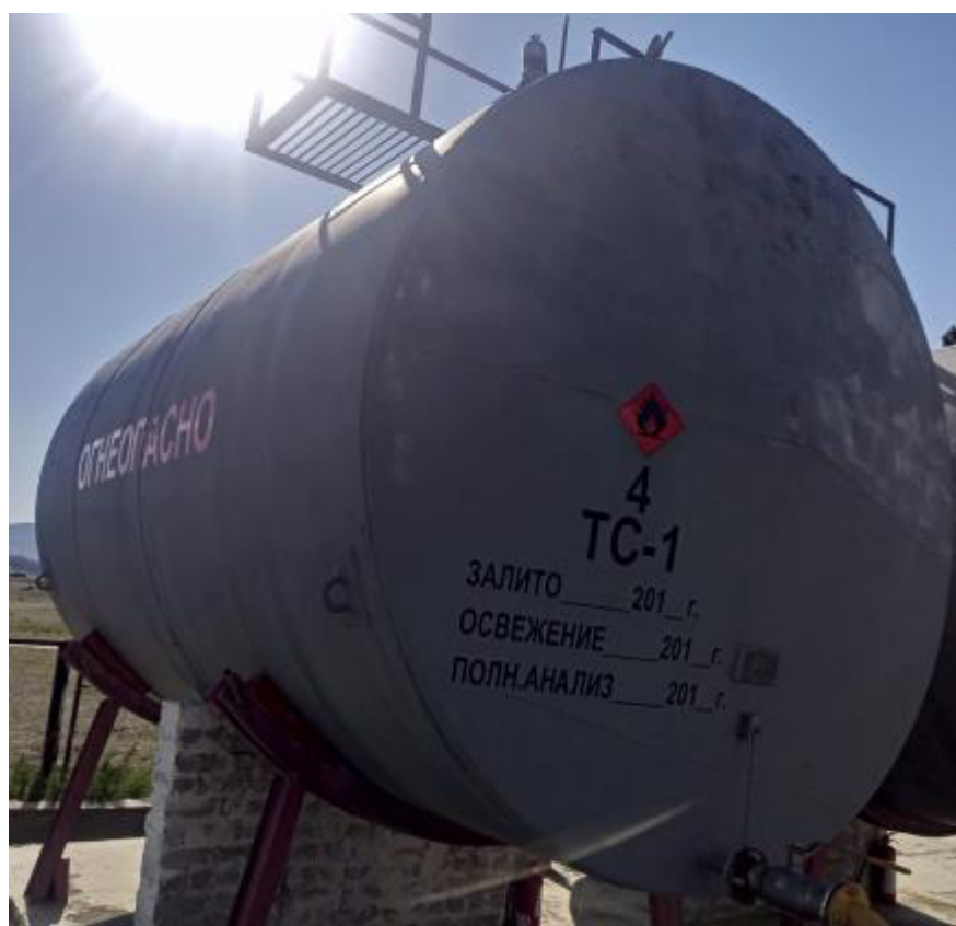
Рисунок 4 – Общий вид резервуара РГС-25 зав.№ 4
