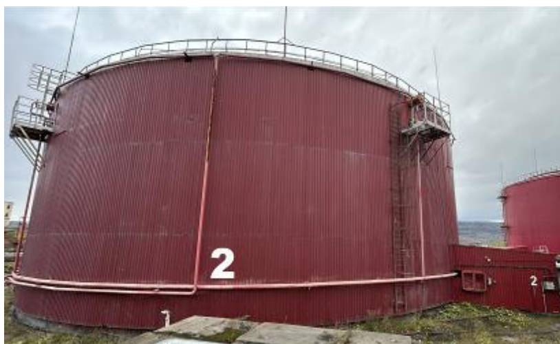
Рисунок 1 – Общий вид резервуара РВС-10000 зав. № 2
