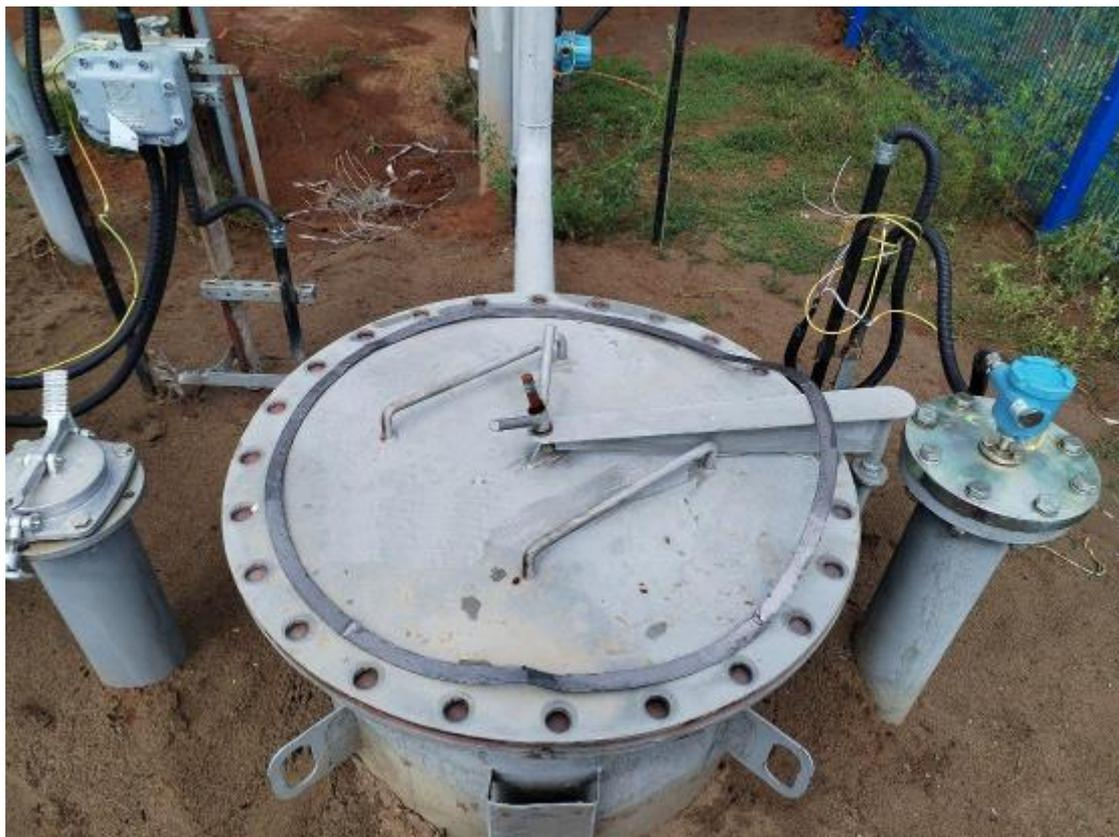
Рисунок 3 – Горловины резервуара ЕП-12,5-1990-1300 зав.№ 161
