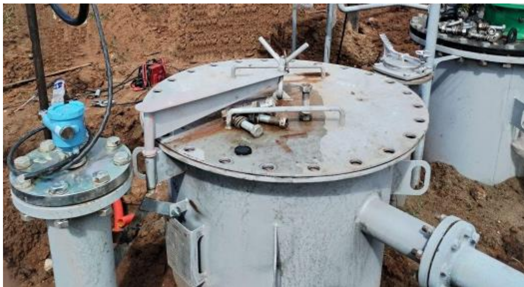
Рисунок 3 – Горловины резервуара ЕП-12,5-1990-1260 зав.№ 160
