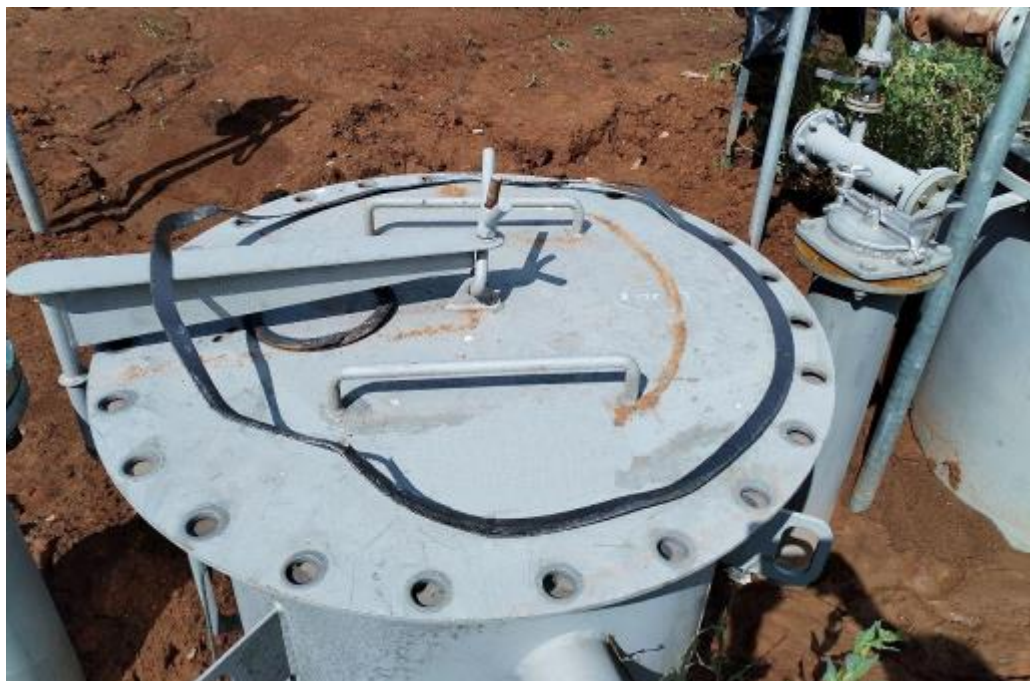
Рисунок 4 – Горловины резервуара ЕП-12,5-1990-1260 зав.№ 165
