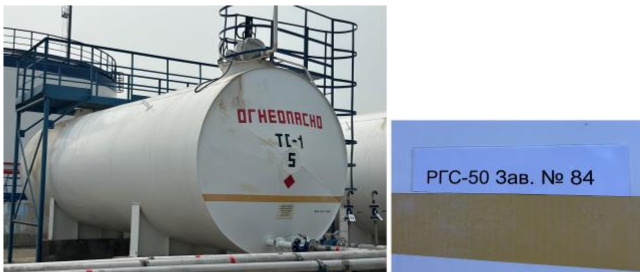
Рисунок 2 – Общий вид резервуара РГС-50 зав.№ 84
