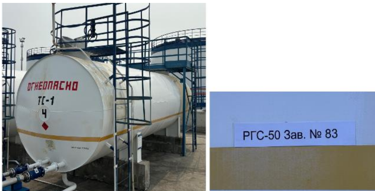
Рисунок 1 – Общий вид резервуара РГС-50 зав.№ 83
