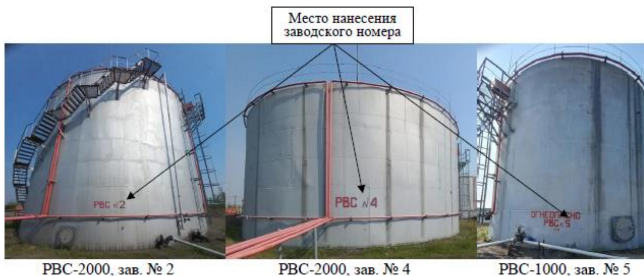
Рисунок 1 – Общий вид резервуаров, зав. № 2, 4, 5
