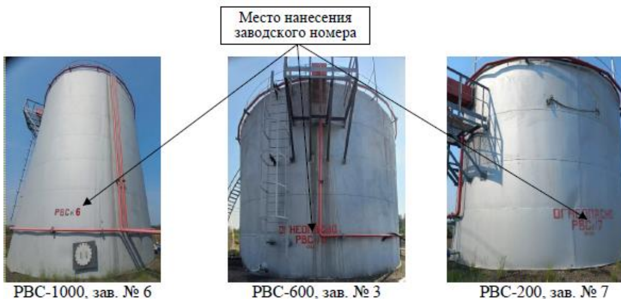
Рисунок 2 – Общий вид резервуаров, зав. № 6, 3, 7
