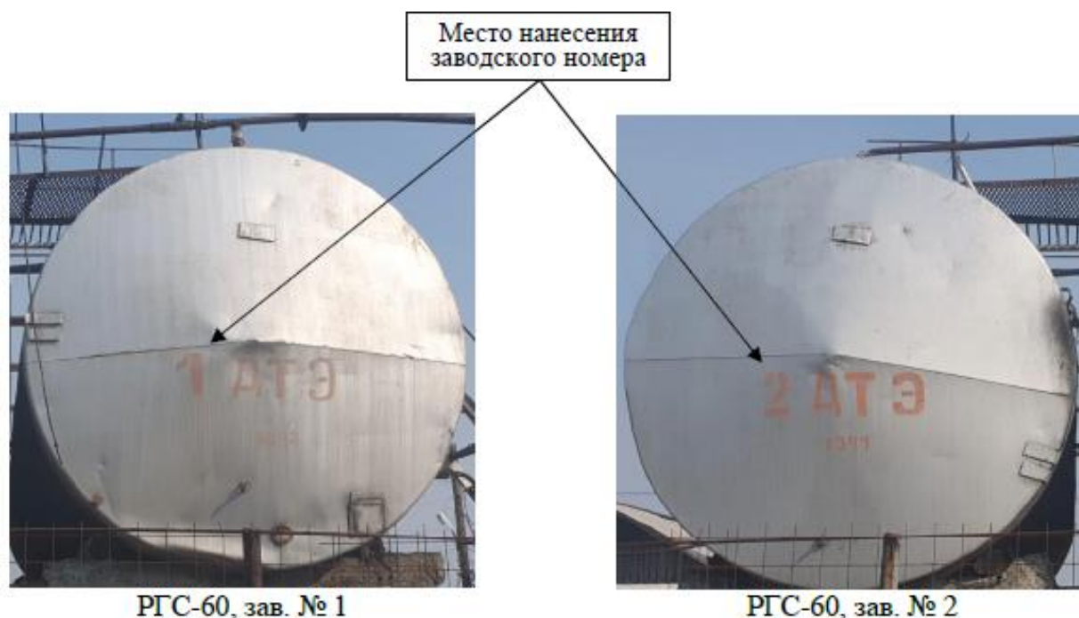
Рисунок 1 – Общий вид резервуаров
