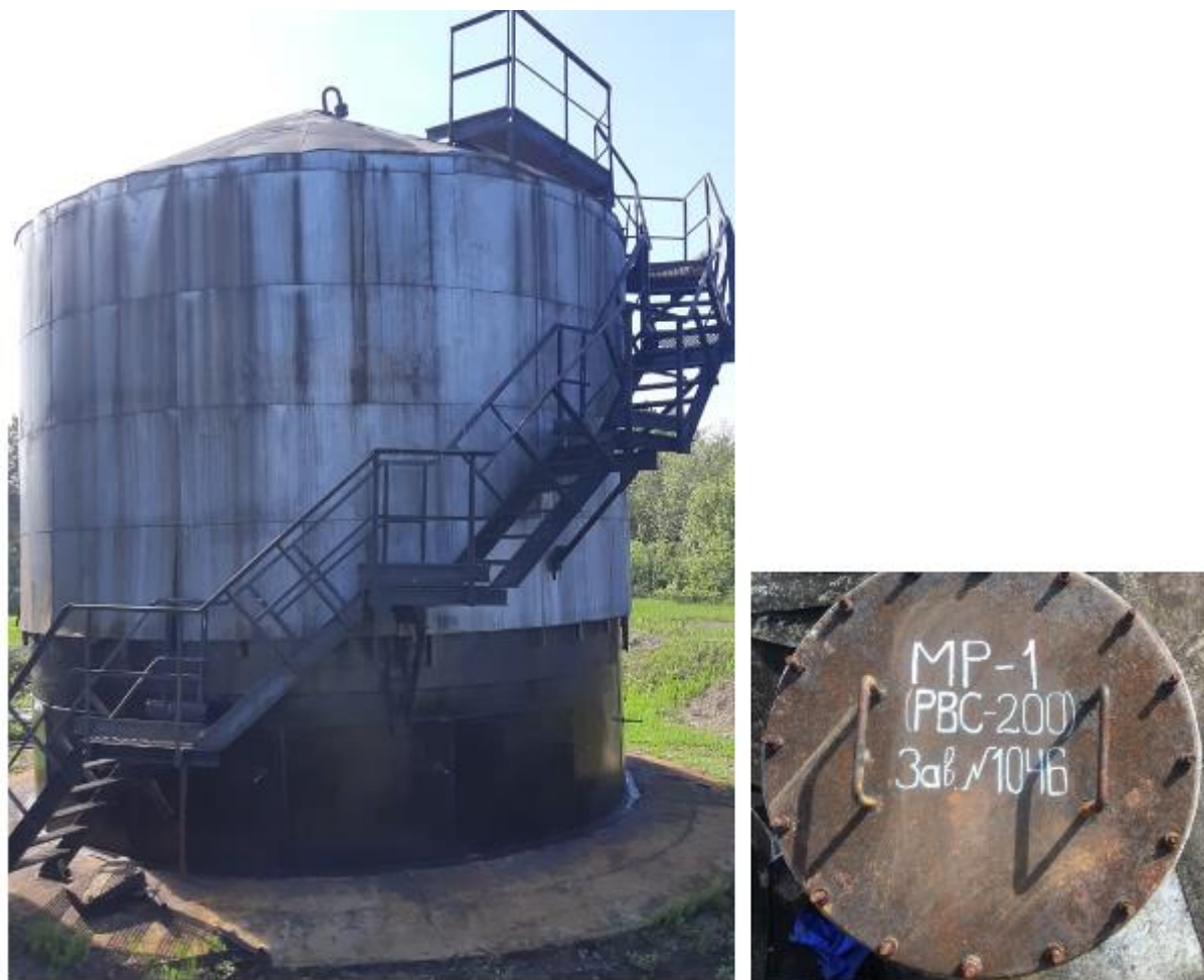
Рисунок 1 – Общий вид резервуара PBC-200
