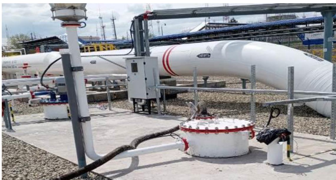
Рисунок 3 – Горловина и измерительный люк резервуара стального горизонтального цилиндрического ЕП-63-3000-1100-А-С-У1
