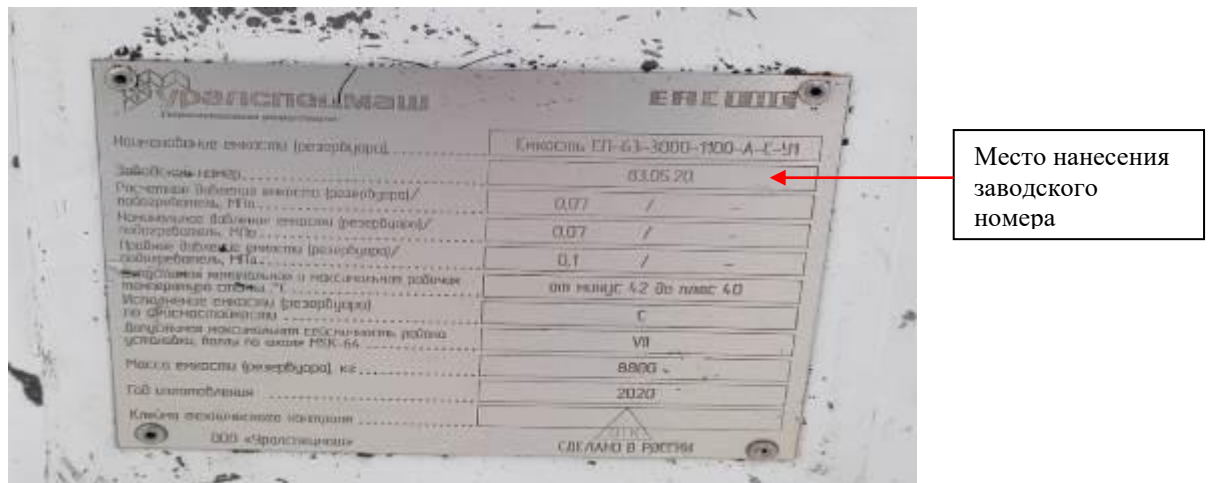
Рисунок 1 – Маркировочная табличка резервуара стального горизонтального цилиндрического ЕП-63-3000-1100-А-С-У1 с местом нанесения заводского номера
