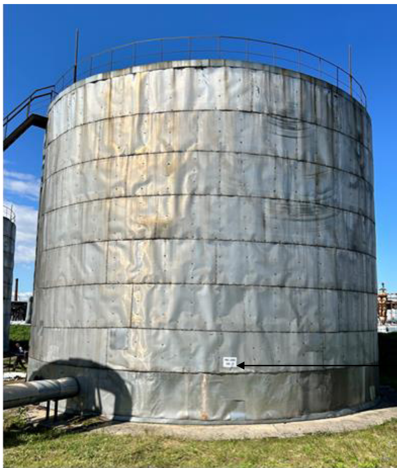
Рисунок 1 – Общий вид резервуара № МБ-2 с указанием места нанесения заводского номера
