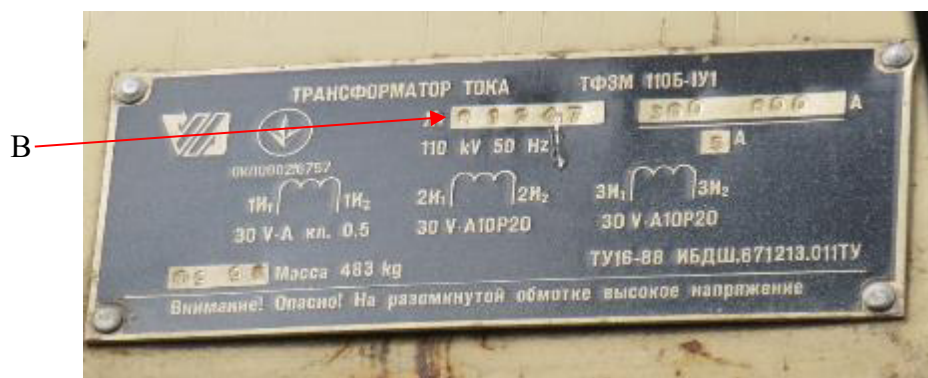
Рисунок 2 – Обозначение места нанесения заводского номера (В)
