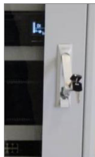
Рисунок 6 – Замок и ключ стойки приборной
