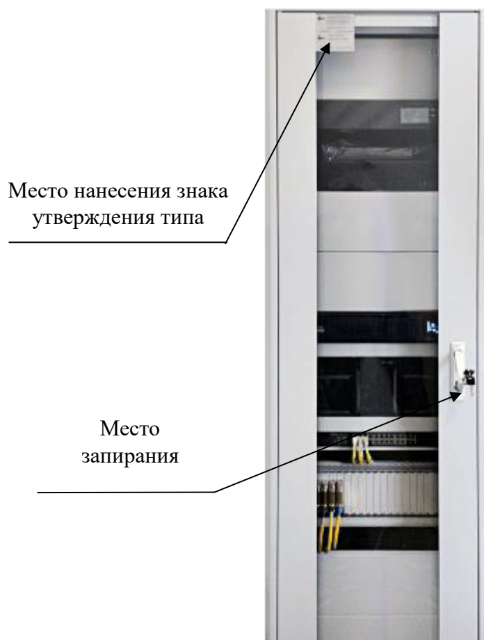
Рисунок 5 – Стойка приборная. Вид общий. Места расположения знаков утверждения типа и запираания стойки приборной
