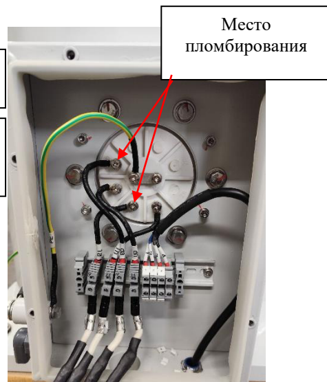
Рисунок 4 – Место пломбирования
