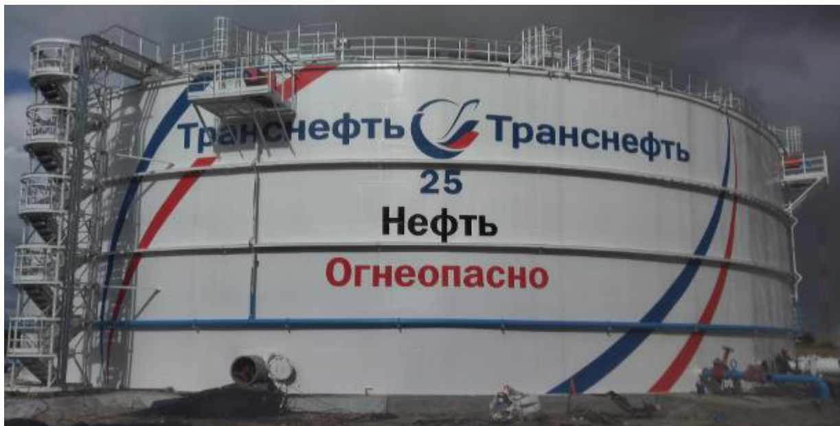
Рисунок 1 – Общий вид резервуара РВСП-20000 № 25
