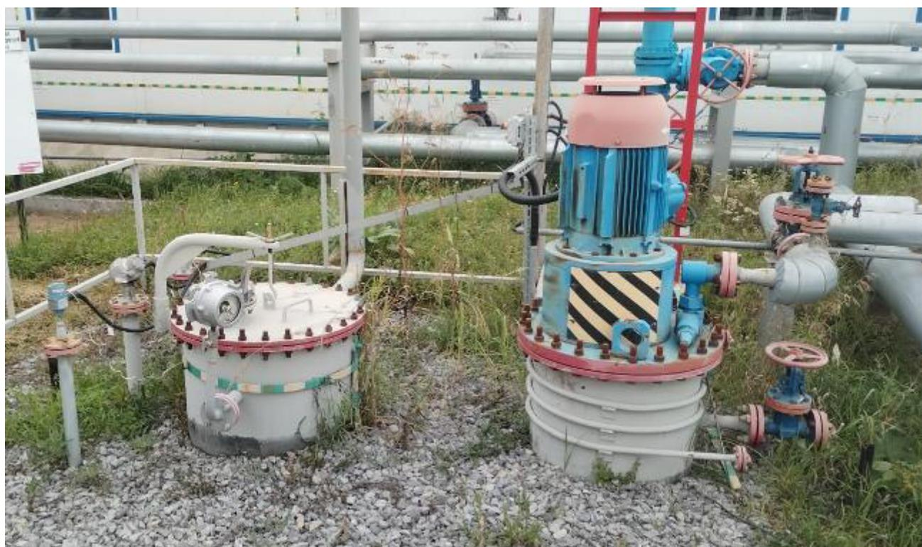
Рисунок 2 – Горловины и измерительный люк резервуара ЕП12,5-2000-1-2-Т
