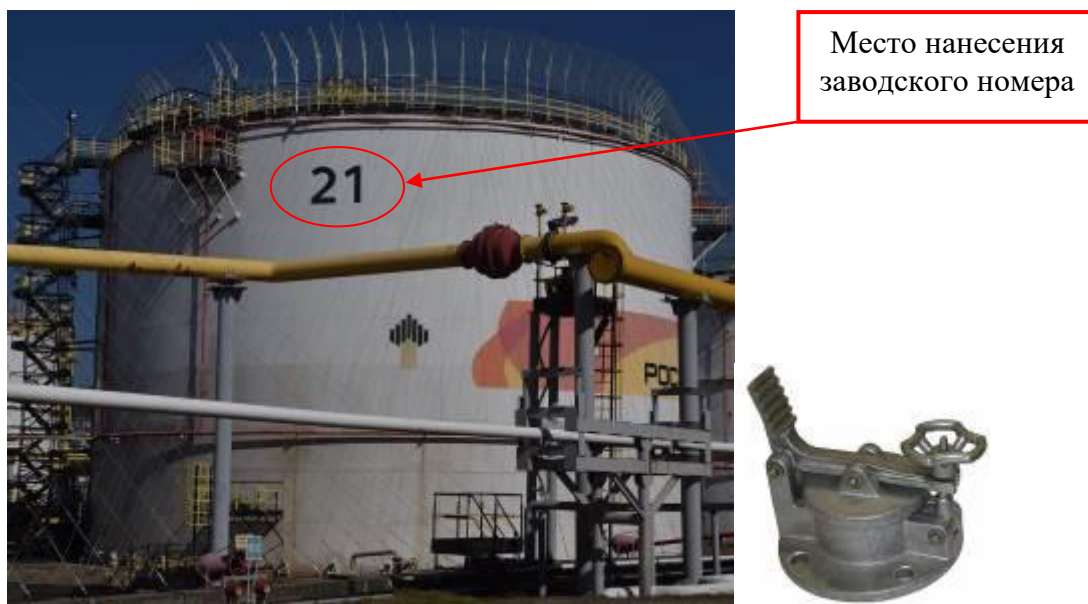
Рисунок 3 – Общий вид резервуара и замерного люка РВСП-10000 зав. № 21
