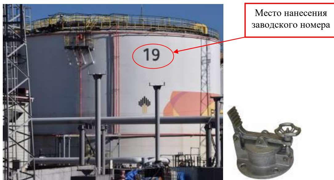
Рисунок 2 – Общий вид резервуара и замерного люка РВСП-10000 зав. № 19
