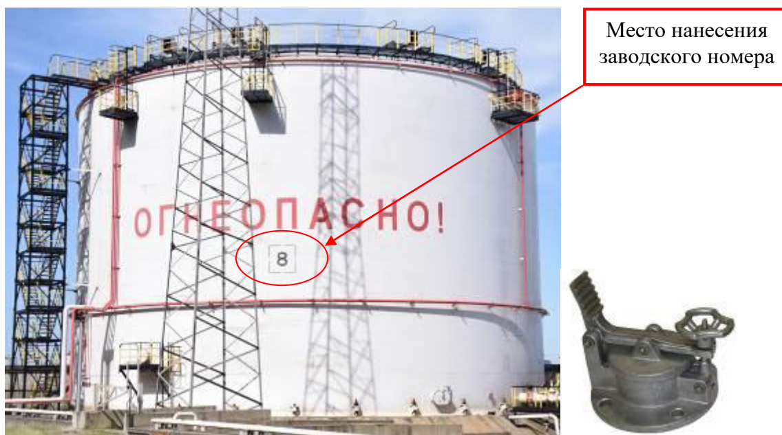
Рисунок 1 – Общий вид резервуара и замерного люка РВСП-10000 зав. № 8
