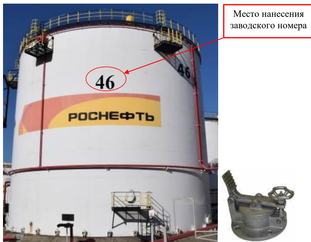
Рисунок 2 – Общий вид резервуара и замерного люка РВСП-5000 зав. № 46
