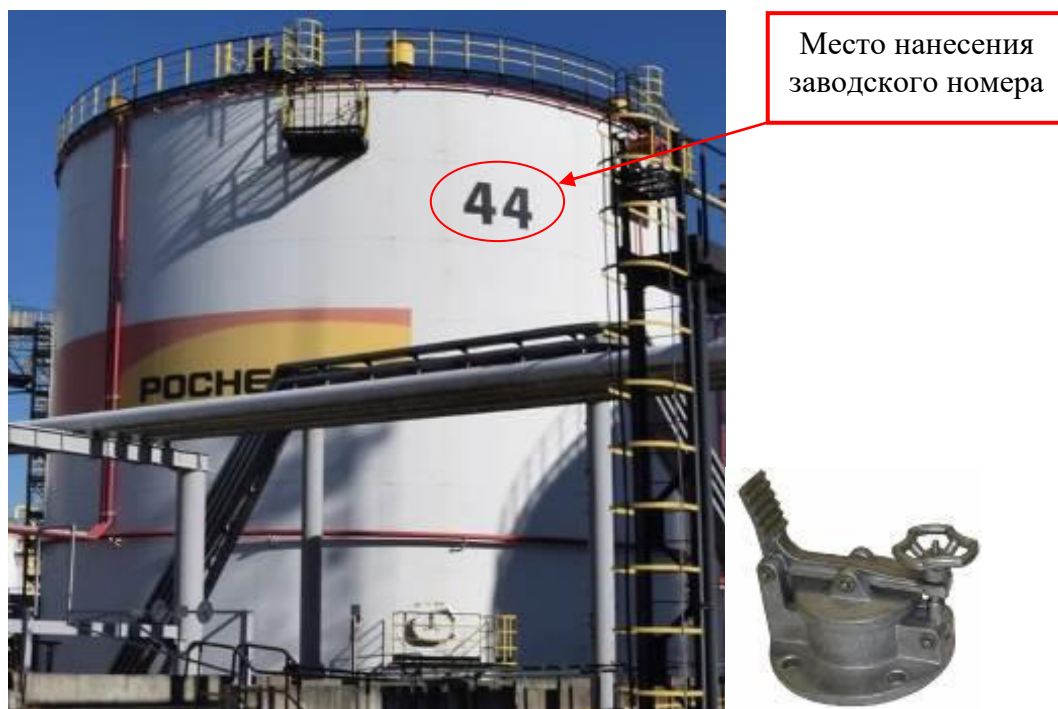
Рисунок 1 – Общий вид резервуара и замерного люка РВСП-5000 зав. № 44
