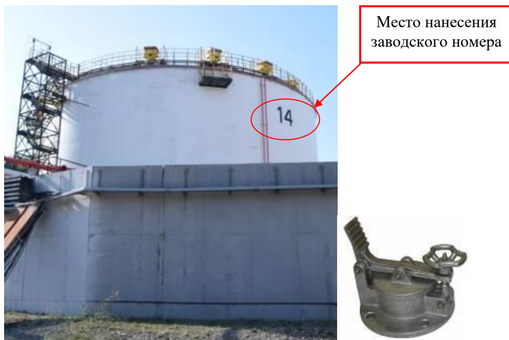
Рисунок 3 – Общий вид резервуара и замерного люка РВС-10000 зав. № 14
