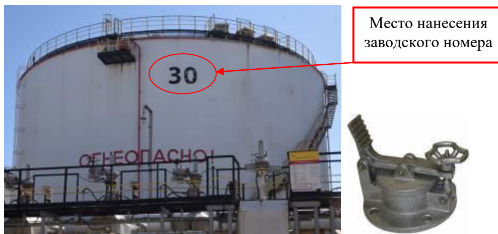
Рисунок 9 – Общий вид резервуара и замерного люка РВС-10000 зав. № 30
