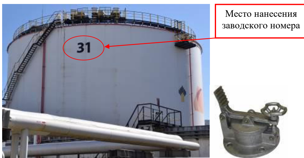
Рисунок 10 – Общий вид резервуара и замерного люка РВС-10000 зав. № 31
