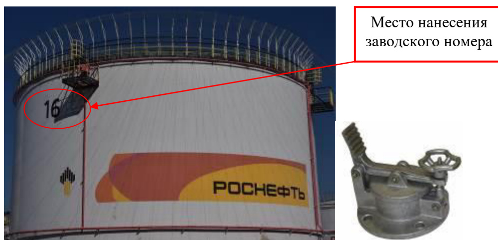
Рисунок 5 – Общий вид резервуара и замерного люка РВС-10000 зав. № 16
