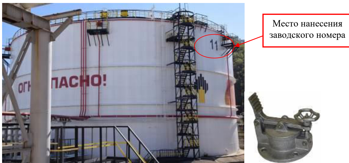
Рисунок 2 – Общий вид резервуара и замерного люка РВС-20000 зав. № 11
