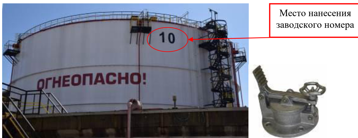
Рисунок 1 – Общий вид резервуара и замерного люка РВС-20000 зав. № 10
