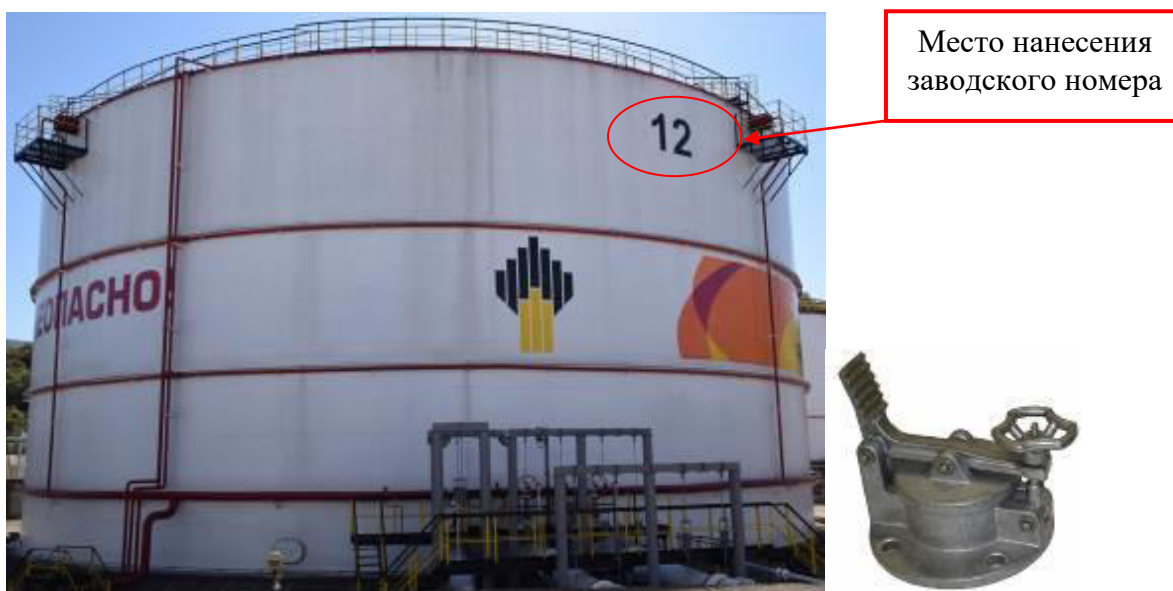
Рисунок 3 – Общий вид резервуара и замерного люка РВС-20000 зав. № 12
