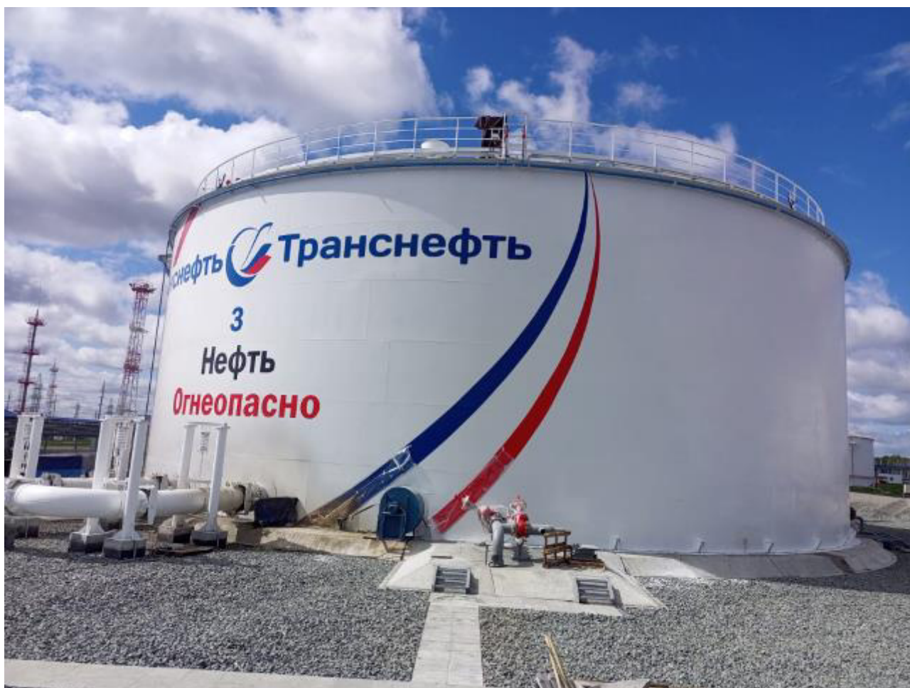
Рисунок 1 – Общий вид резервуара РВС-10000 №3
