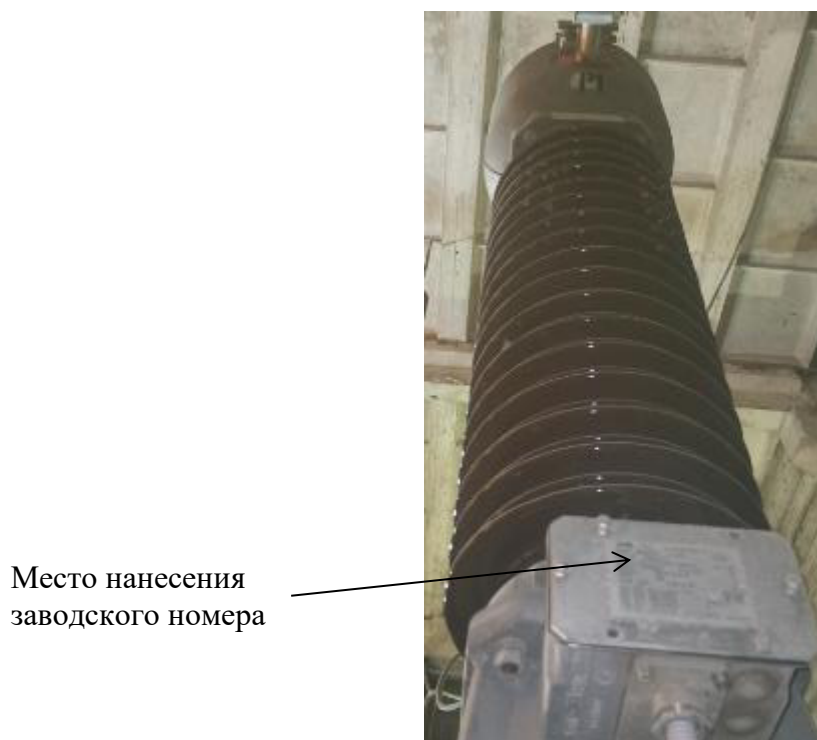
Рисунок 1 – Общий вид трансформатора тока с указанием места нанесения заводского номера
