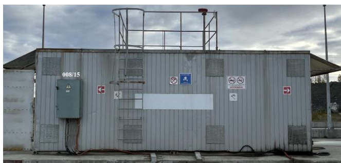
Рисунок 1 – Общий вид резервуара РГС-20 зав. № 008/15
