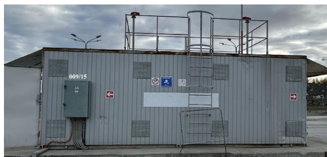
Рисунок 2 – Общий вид резервуара РГС-20 зав. № 009/15
