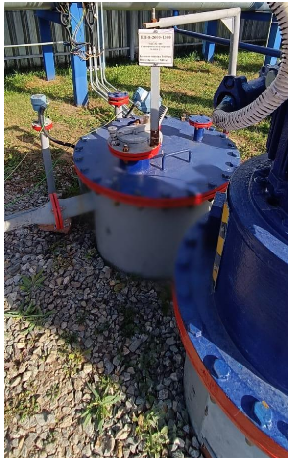
Рисунок 2 – Горловины и измерительный люк резервуара ЕП-8-2000-1300
