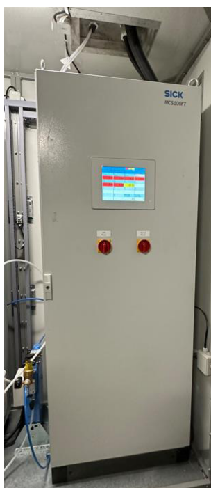
Рисунок 4 – Общий вид газоаналитического комплекса MCS100FT
