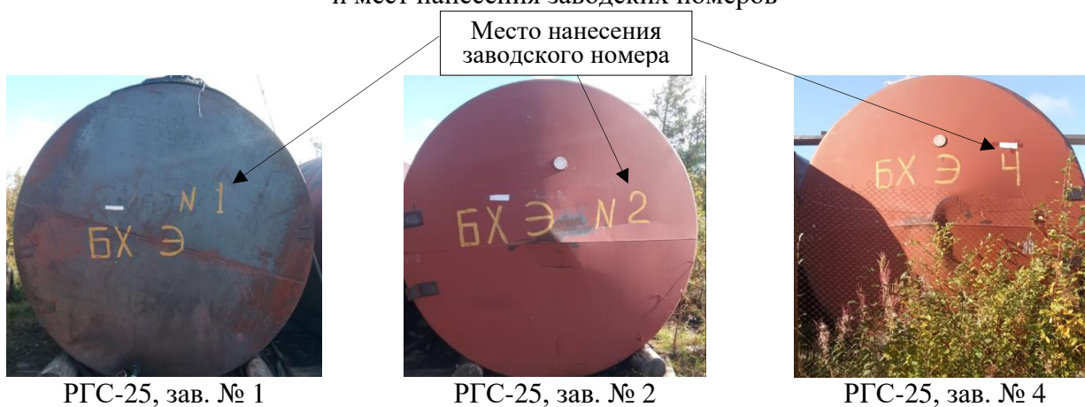
Рисунок 2 – Общий вид резервуаров модификации РГС-25 и мест нанесения заводских номеров
