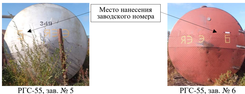
Рисунок 1 – Общий вид резервуаров модификации РГС-55 и мест нанесения заводских номеров
