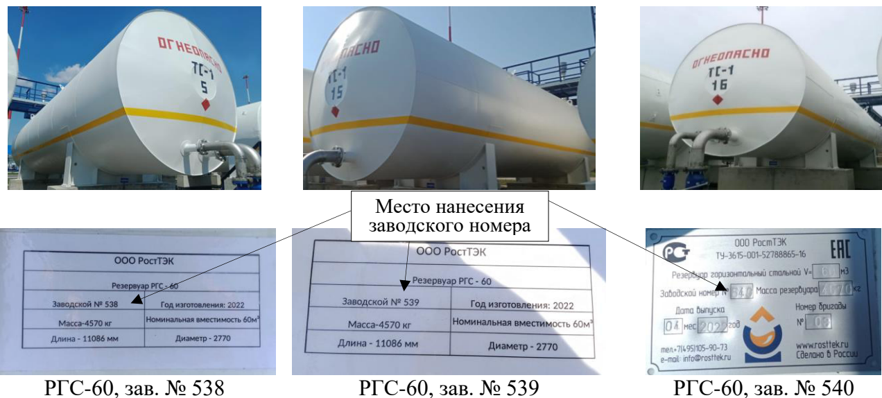
Рисунок 1 – Общий вид резервуаров модификации РГС-60, зав. №№ 538, 539, 540, табличек и мест нанесения заводских номеров
