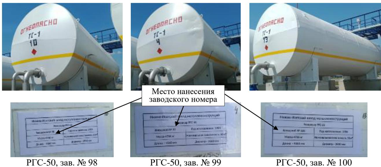
Рисунок 1 – Общий вид резервуаров модификации ТС-50, зав. №№ 98, 99, 100, табличек и мест нанесения заводских номеров
