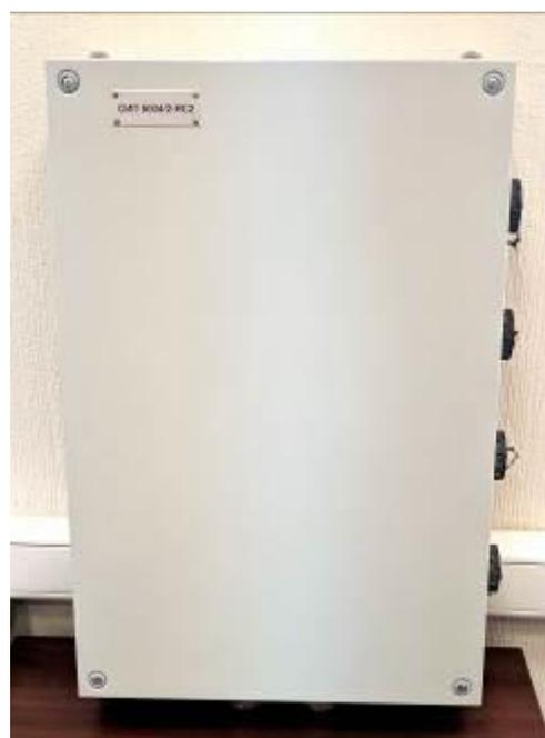
Рисунок 2 – Ящик соединительный СИП 5004-ЯС из состава наземной кабельной сети СИП 5004-НКС
