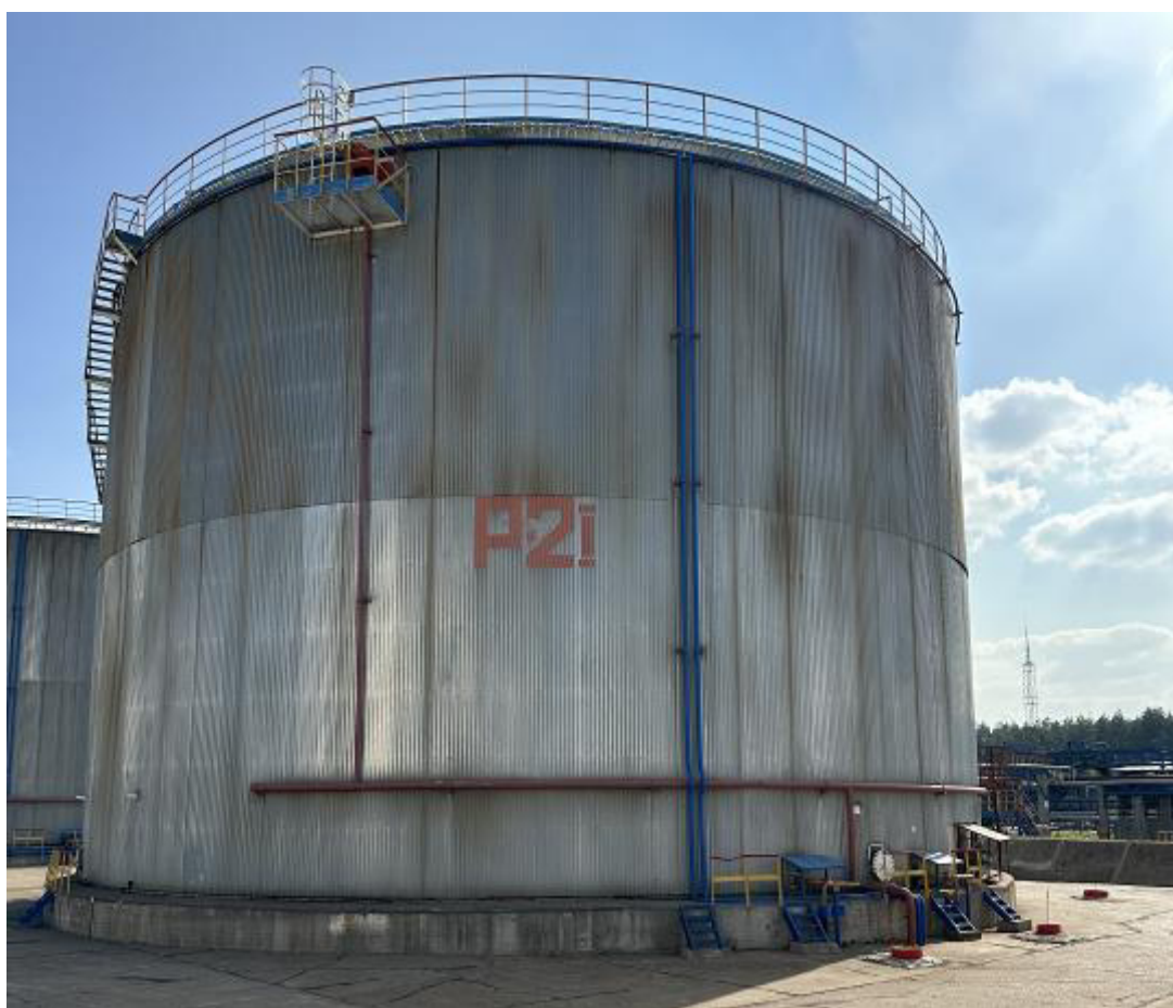
Рисунок 2 – Общий вид резервуара РВСП-10000
