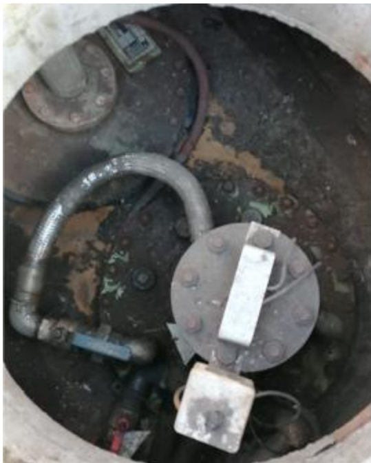
Рисунок 2 – Маркировочная табличка и горловины резервуара РГС-50 зав.№ 141
