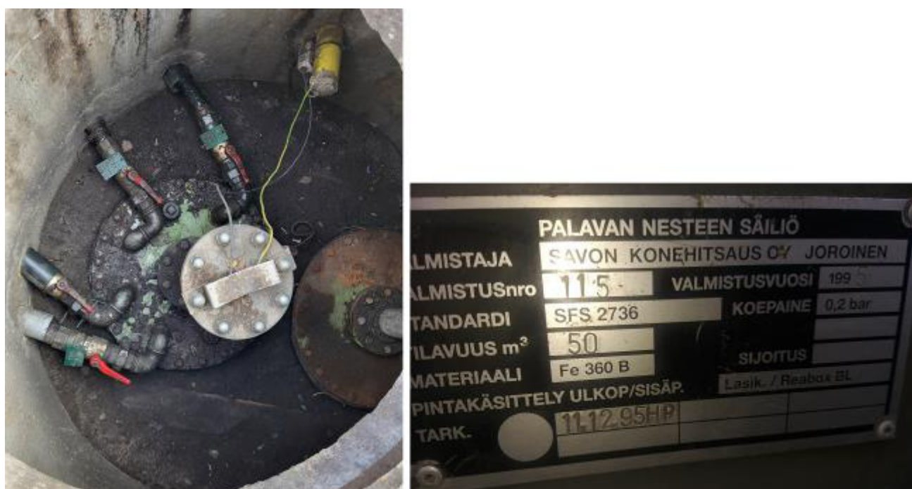
Рисунок 6 – Маркировочная табличка и горловины резервуара РГС-50 зав.№ 115
