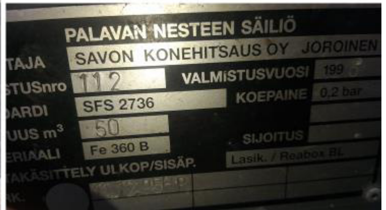
Рисунок 3 – Маркировочная табличка и горловины резервуара РГС-50 зав.№ 112
