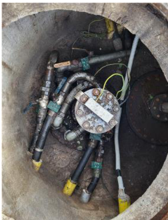
Рисунок 2 – Маркировочная табличка и горловины резервуара РГС-50 зав.№ 111
