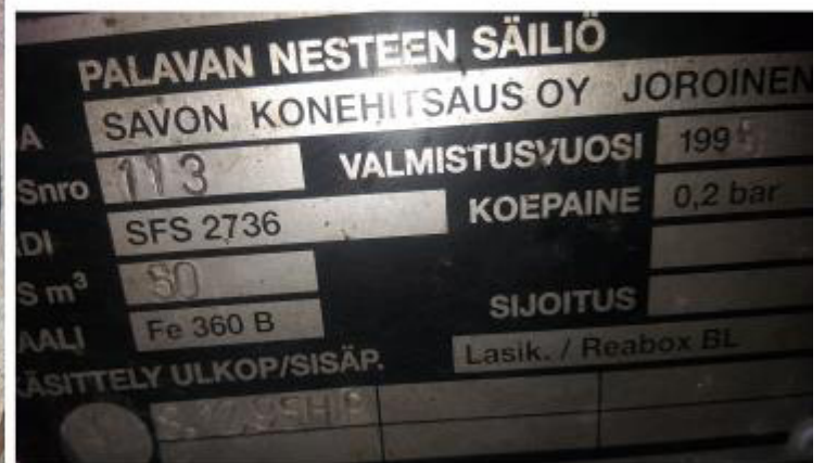
Рисунок 4 – Маркировочная табличка и горловины резервуара РГС-50 зав.№ 113
