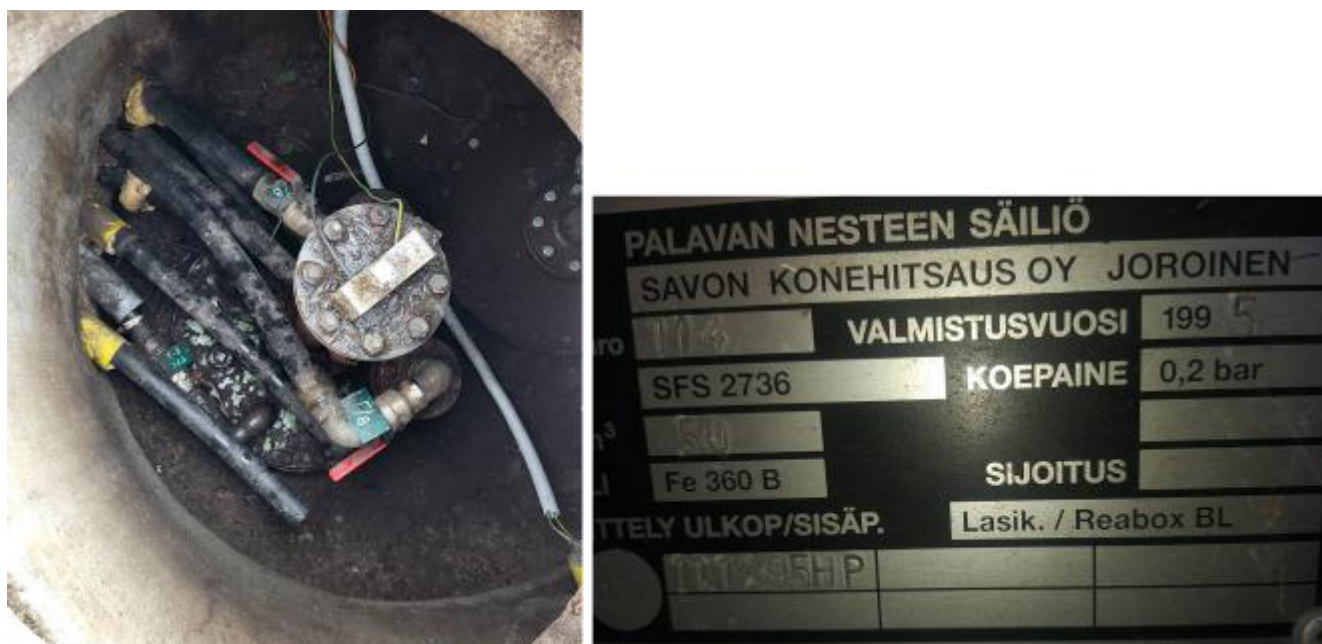
Рисунок 5 – Маркировочная табличка и горловины резервуара РГС-50 зав.№ 114
