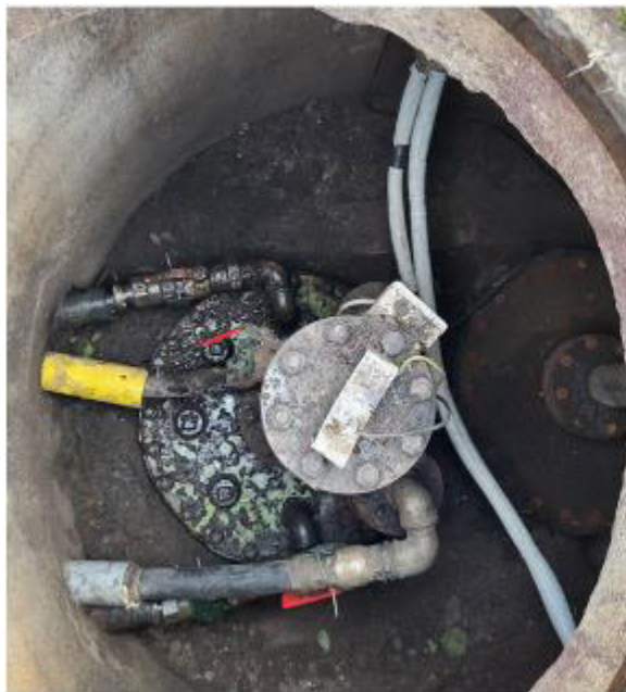
Рисунок 4 – Маркировочная табличка и горловины резервуара РГС-50 зав.№ 113
