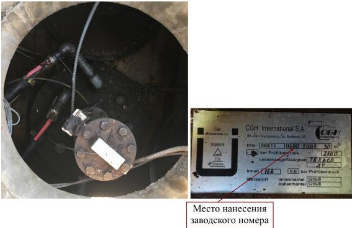
Рисунок 3 – Маркировочная табличка и горловины резервуара РГС-30 зав.№ 1090
