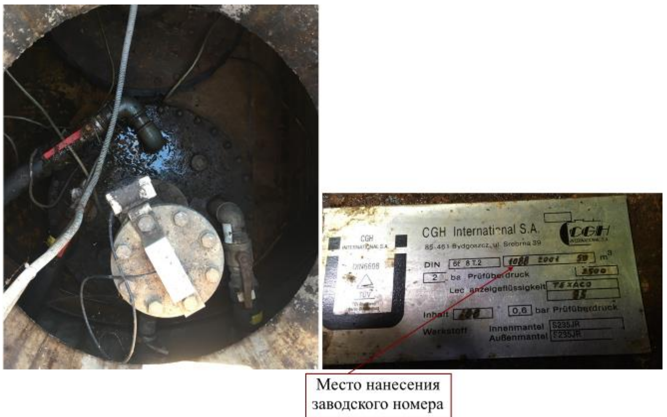
Рисунок 4 – Маркировочная табличка и горловины резервуара РГС-50 зав.№ 1088
