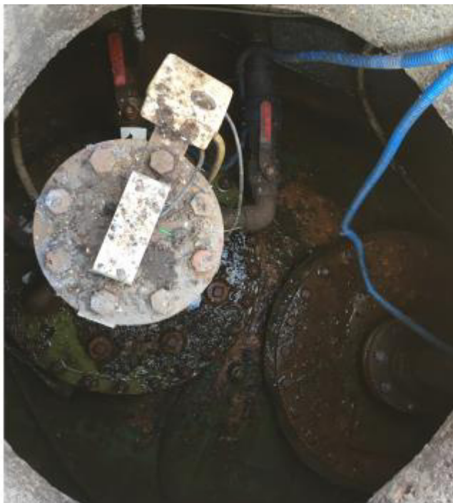
Рисунок 2 – Маркировочная табличка и горловины резервуара РГС-30 зав.№ 1685
