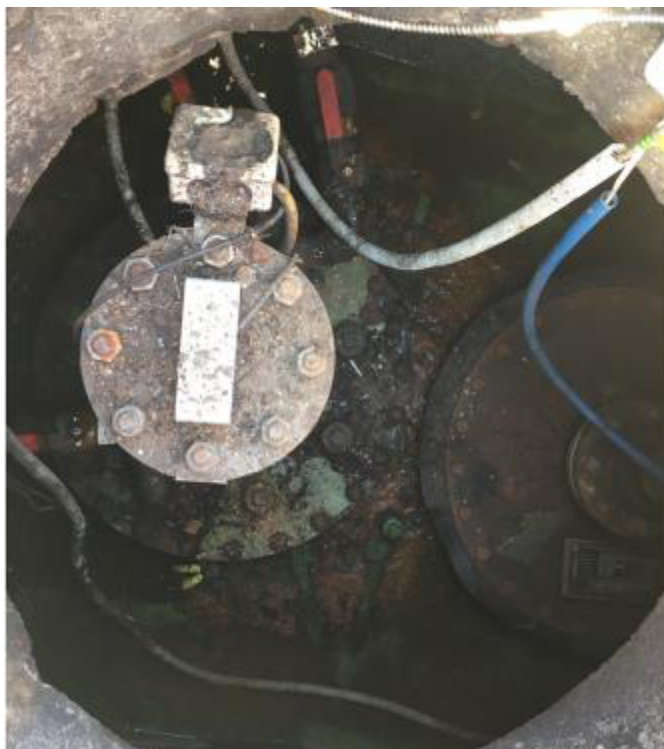
Рисунок 4 – Маркировочная табличка и горловины резервуара РГС-50 зав.№ 1687
