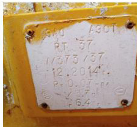
Рисунок 4 – Маркировочная табличка и горловины резервуара РТ 37 зав.№ 373/37
