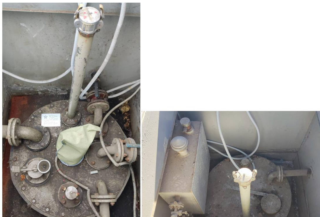
Рисунок 3 – Горловины резервуара РГ50 ((40)+(10)) зав.№ 126
