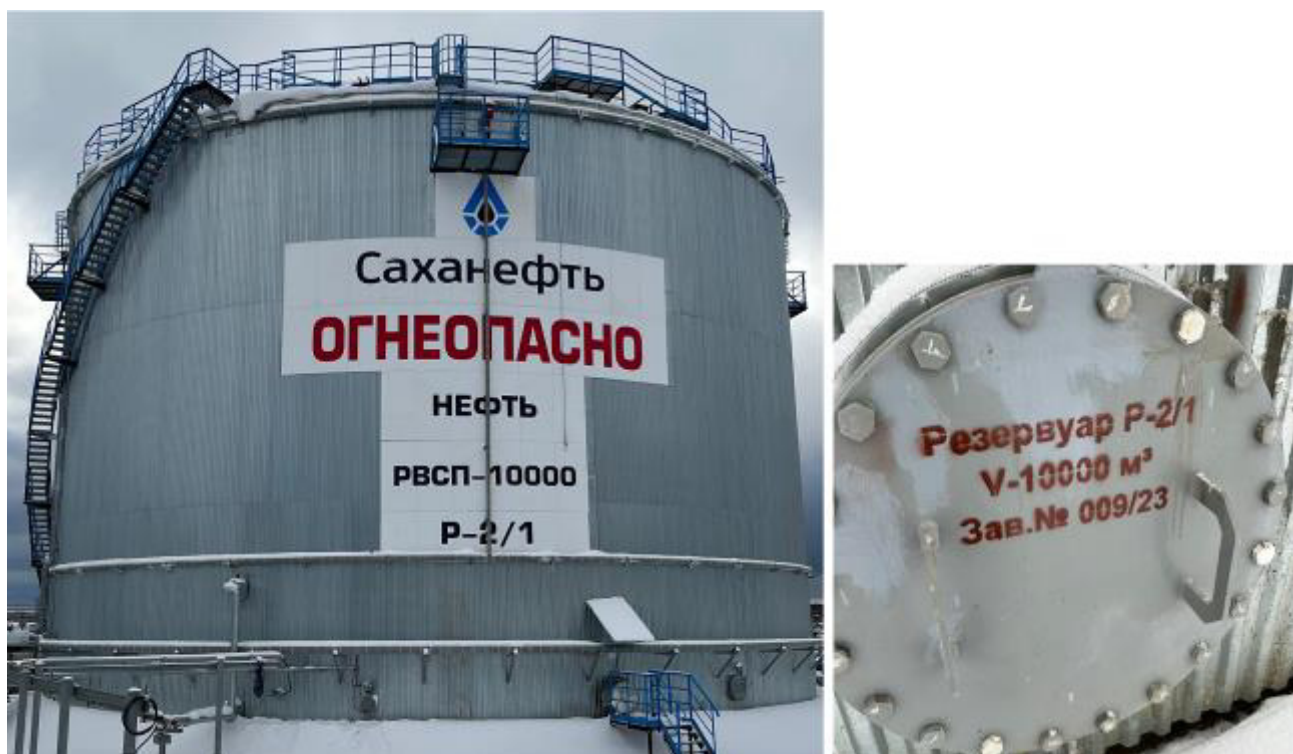
Рисунок 1 – Общий вид резервуара РВСП-10000 зав.№ 009/23 и место нанесения заводского номера
