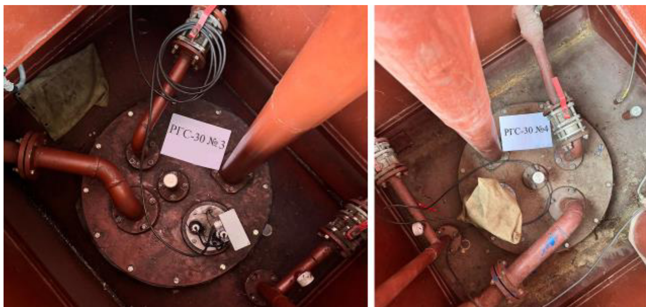
Рисунок 3 – Горловины резервуаров РГС-30 зав.№№ 3, 4
