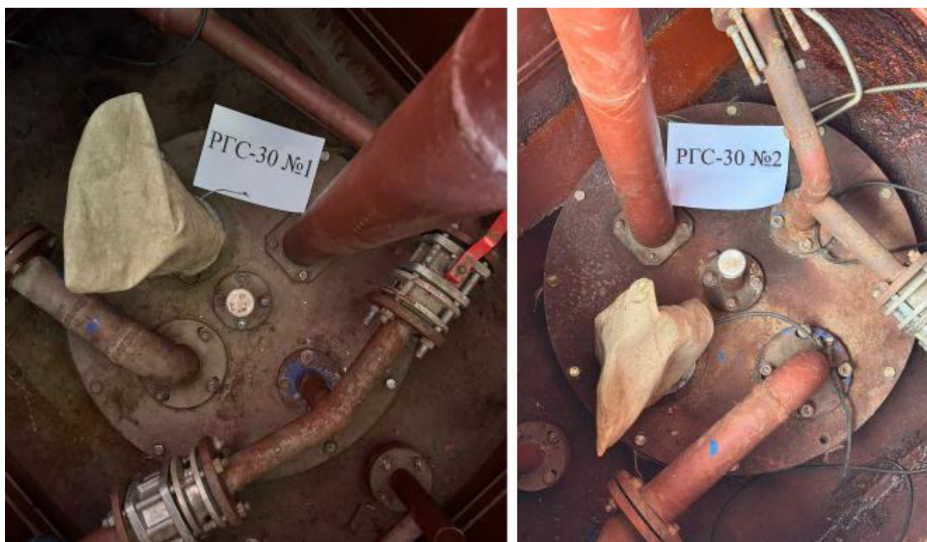
Рисунок 2 – Горловины резервуаров РГС-30 зав.№№ 1, 2
