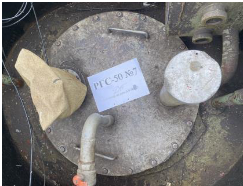
Рисунок 5 – Горловина резервуара РГС-50 зав.№ 7
