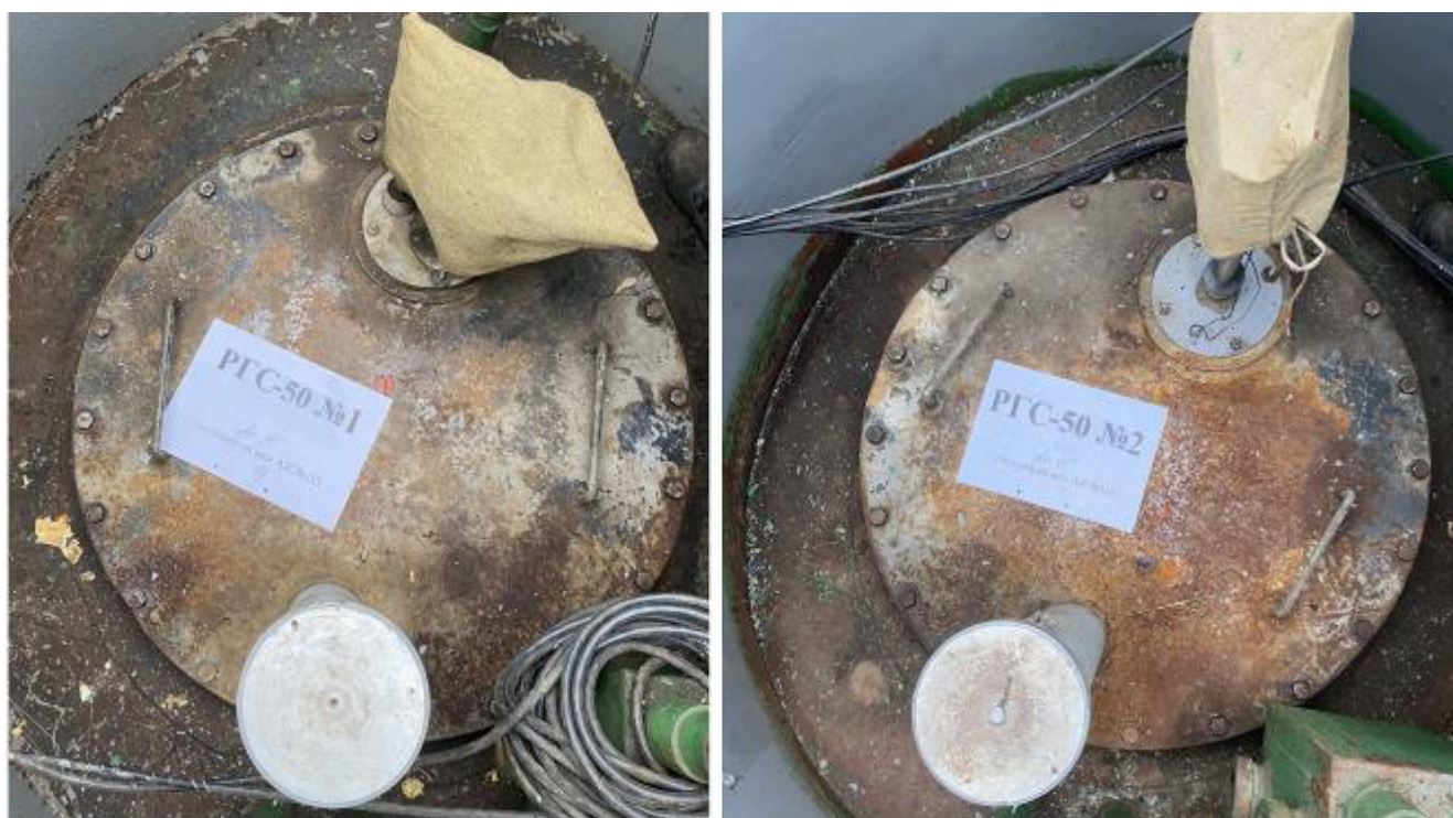
Рисунок 2 – Горловины резервуаров РГС-50 зав.№№ 1, 2
