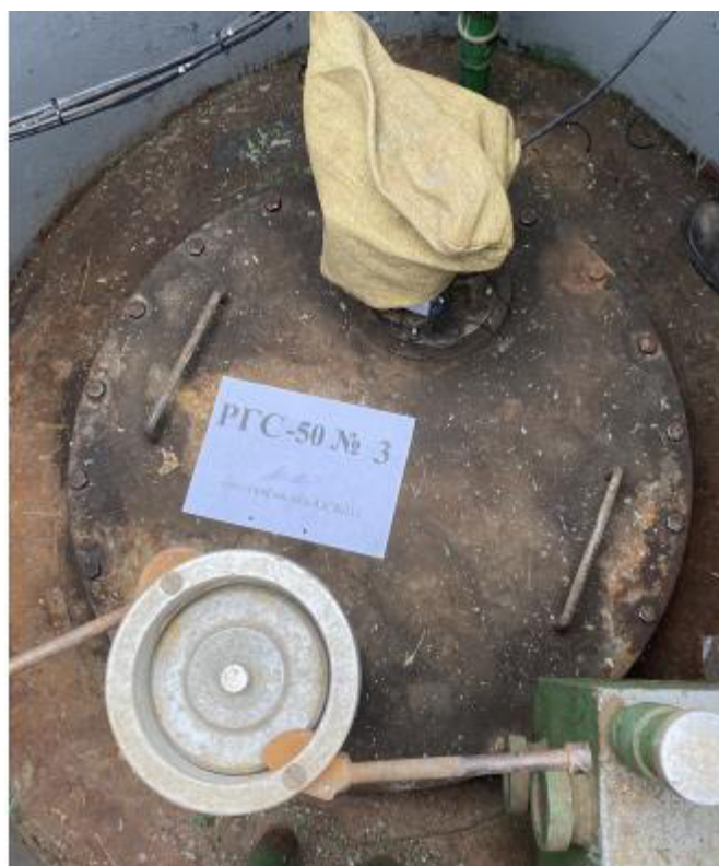
Рисунок 3 – Горловины резервуаров РГС-50 зав.№№ 3, 4
