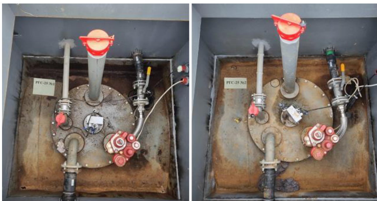
Рисунок 2 – Горловины резервуаров РГС-25 зав.№№ 1, 2
