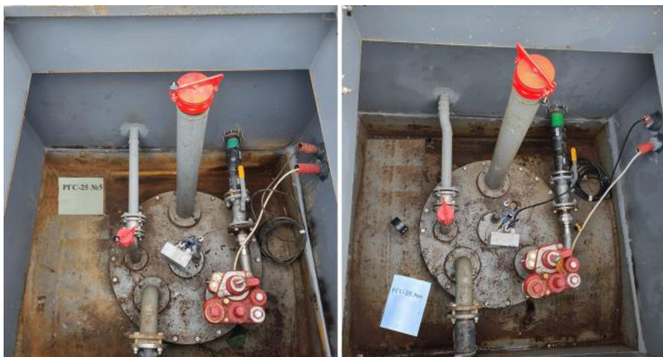
Рисунок 4 – Горловины резервуаров РГС-25 зав.№№ 5, 6
