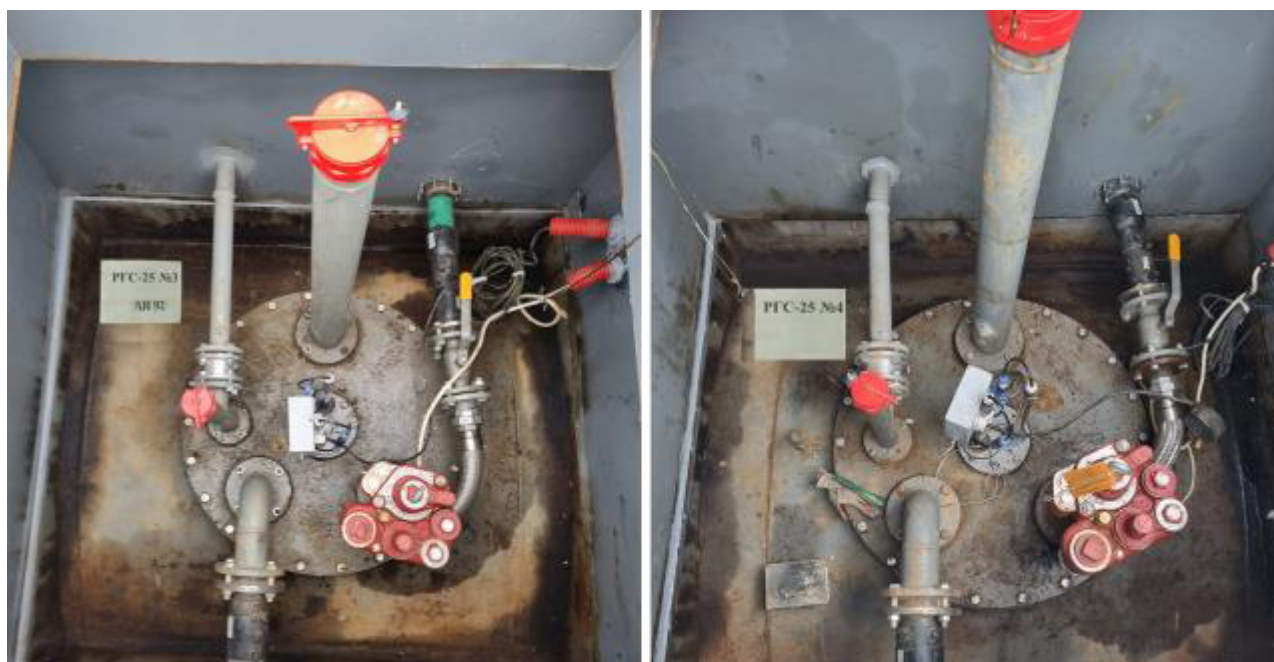
Рисунок 3 – Горловины резервуаров РГС-25 зав.№№ 3, 4
