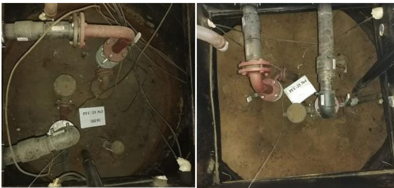
Рисунок 3 – Горловины резервуаров РТС-25 зав.№№ 3, 4
